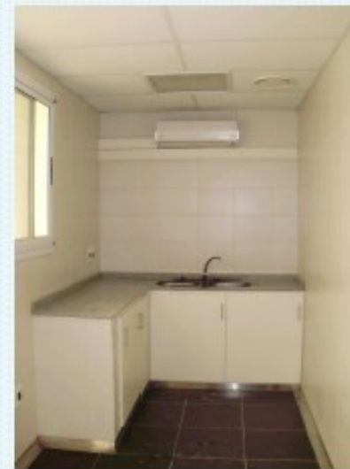
Terminación en enfermería.
