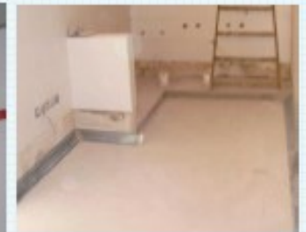
Revestimiento cerámico, colocación de zócalos sanitarios en enfermería
