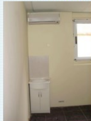
Colocación de equipos de aire acondicionado en consultorios
