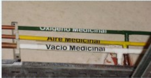
Terminaciones en Inst. de Gases Medicinales
