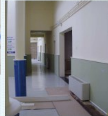
Colocación de equipos fan coil.
