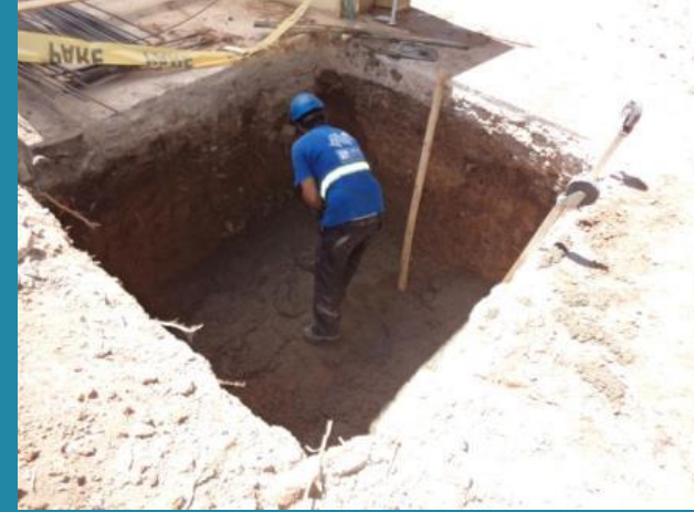
Excavaciones para cimientos
